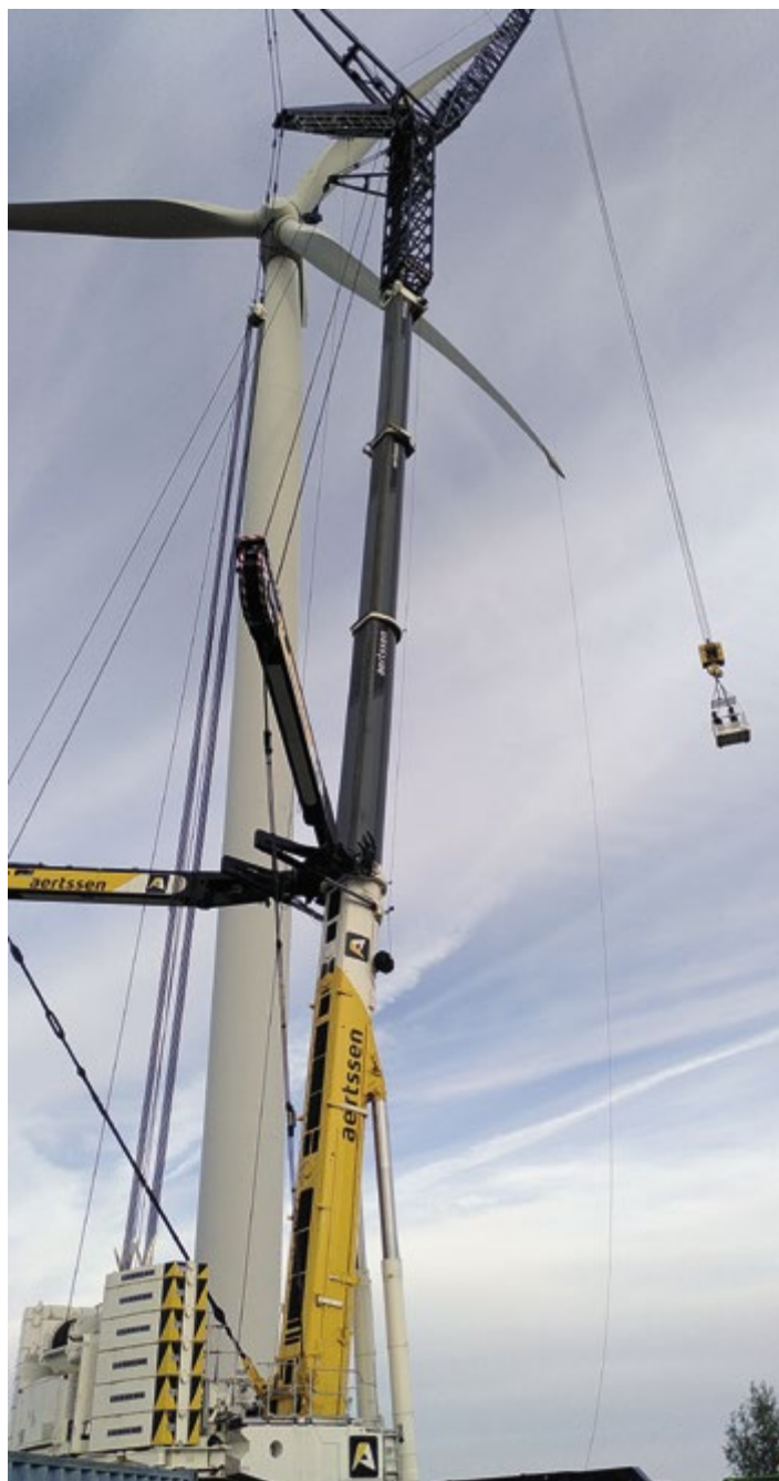
vervanging hoofdlager Bredekop turbine
