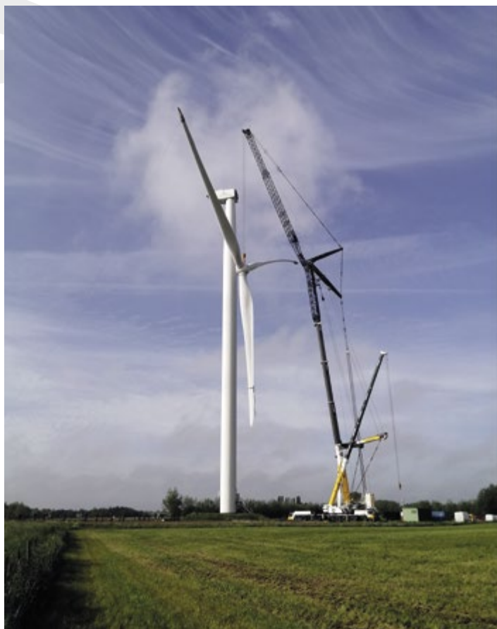
vervanging hoofdlager Bredekop turbine
